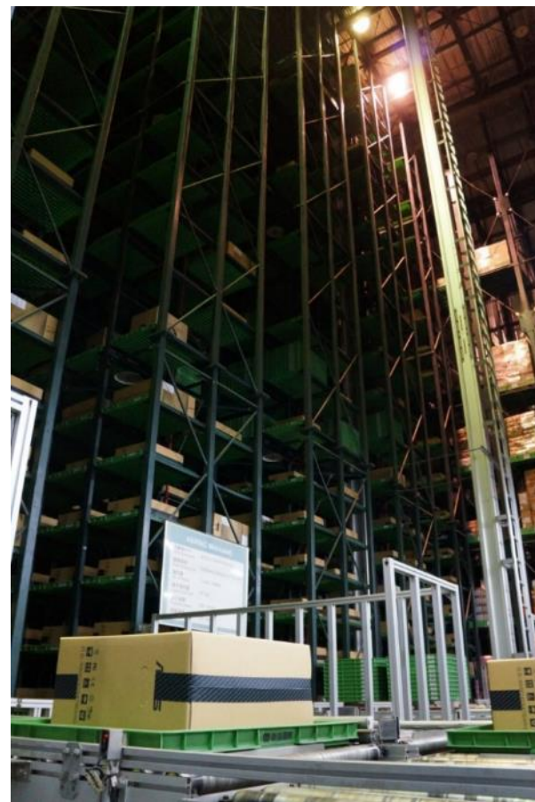
台北運籌中心全自動智能倉儲系統
